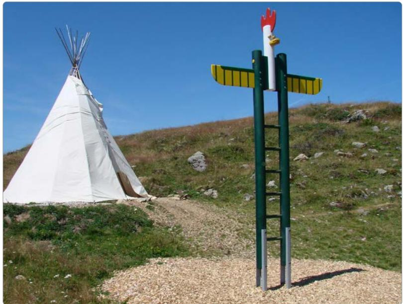
Beschreibung: 1 Doppelsteher aus 2 Rundhölzern Ø 14 cm, durch Klettersprossen Ø 4,5 cm verbunden und verschraubt, Flügel aus Sperrholzplatten, wasserfest verleimt, färbige Gestaltung des Kopfes und der Flügel.
